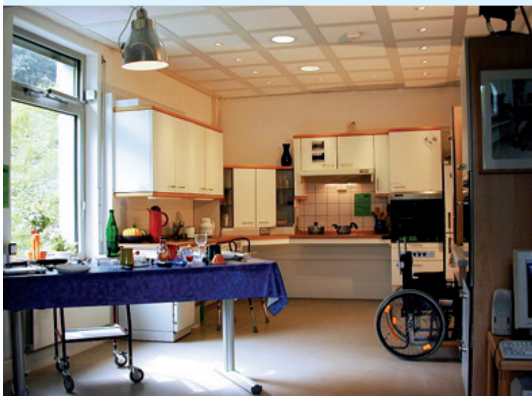
Rollstuhlgerechte Küche der Versuchswohnung. Arbeitsplatte, Herd und Spüle sind unterfahrbar.
