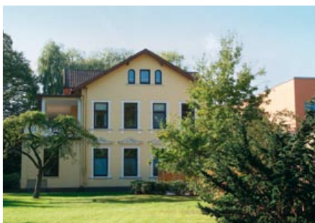
Krankenhaus Stenum: Haupthaus aus dem Jahr 1926
